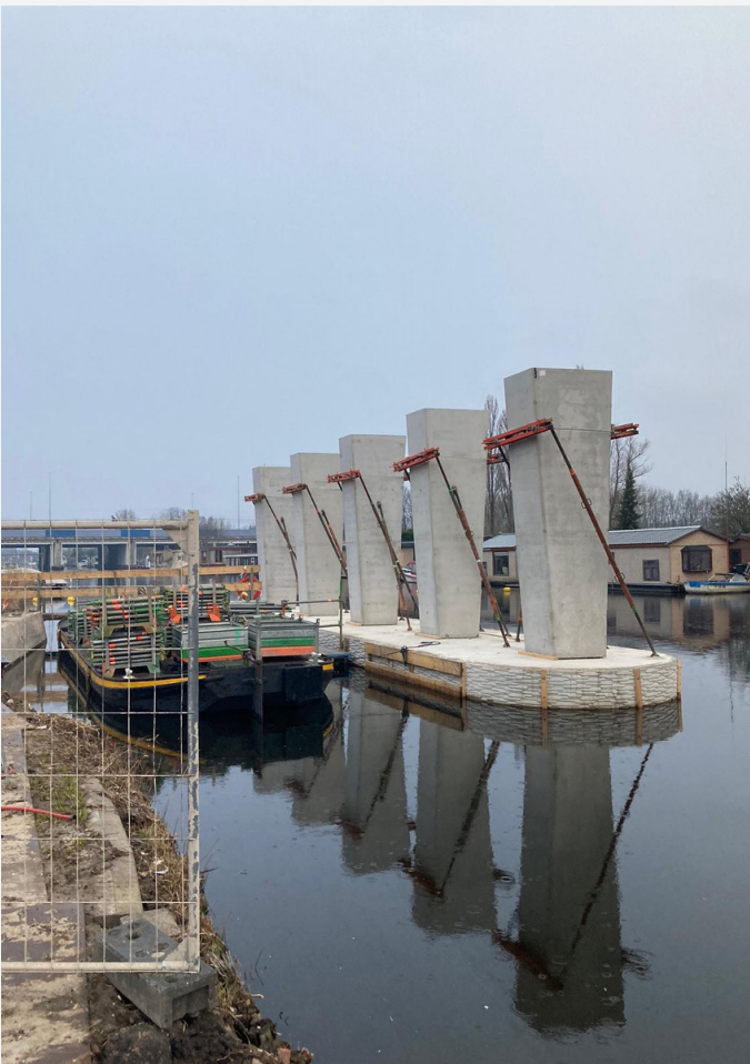
De kolommen van as 3 zijn geplaatst op de poer in de Ringvaart
