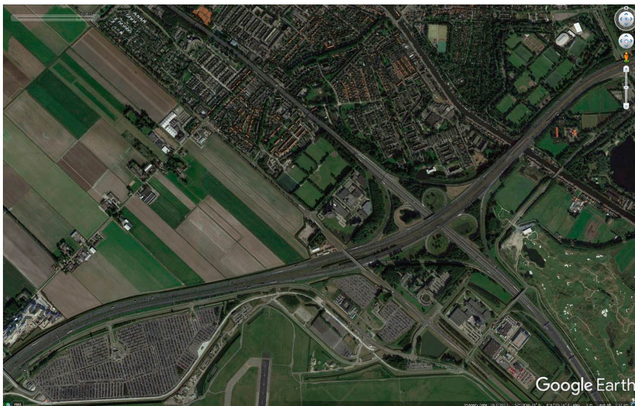
Figuur A-1: Situatie in oktober 2013. Rijksweg A9 loopt door Badhoevedorp
